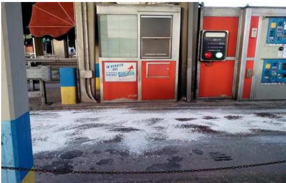
Applicazione minerali assorbenti presso casello autostradale
