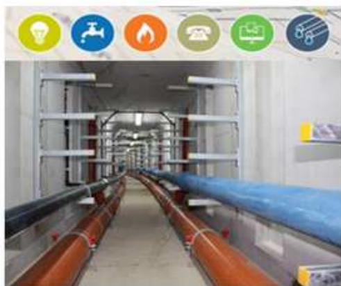
Galleria in fase di realizzazione
